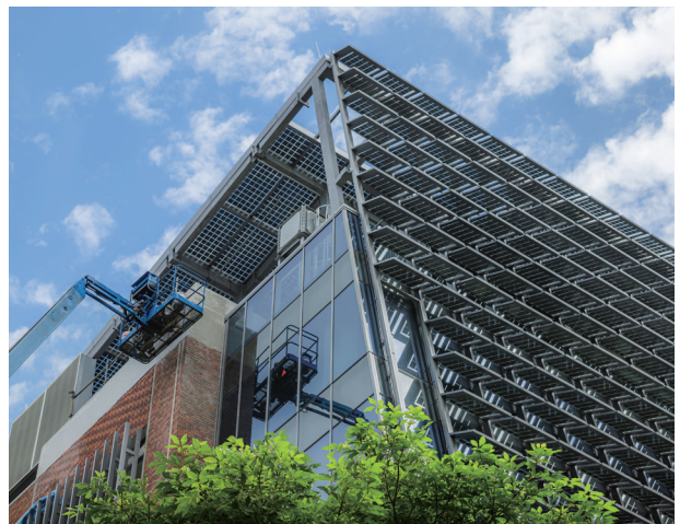
写真3 “Greenhouse” 北側ファサードのBIPV水平フィン
