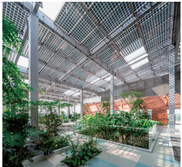
写真2 “Greenhouse” 屋上庭園のBIPVルーフ 2
