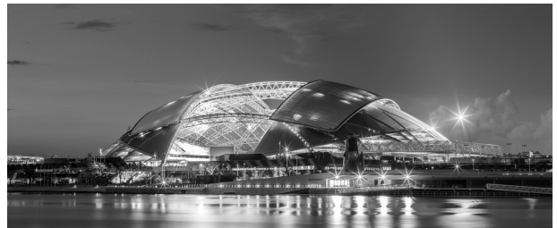
(Photo : Courtesy of DP Architects) フッ素樹脂フィルム施工例
