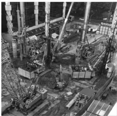
写真 2-2 山留壁構築作業時
