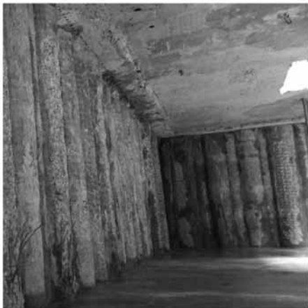
写真 2-1 柱列式地下連続壁出来型
