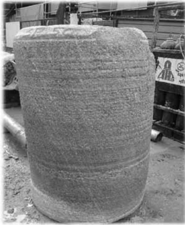
写真 3-1 山留壁構築時
