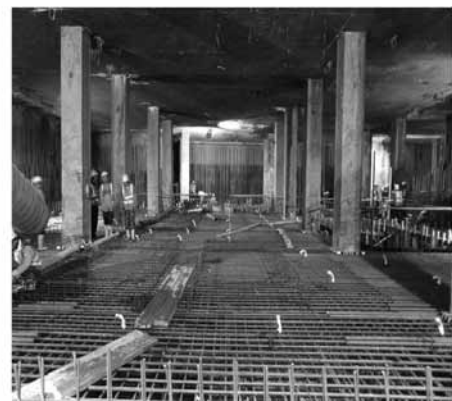
写真 2-4 躯体構築作業時
