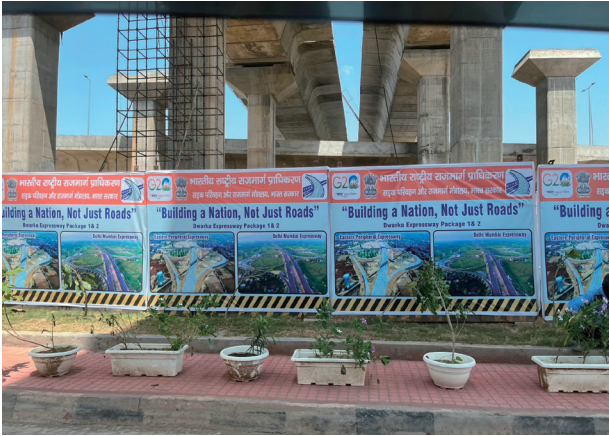
建設が進む工事現場「Building Nation, not a Road」
