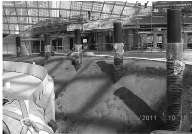
図8 植栽エリアのラウンドタイプ吹出口
