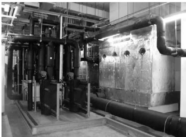
図14 吸収式冷凍機
