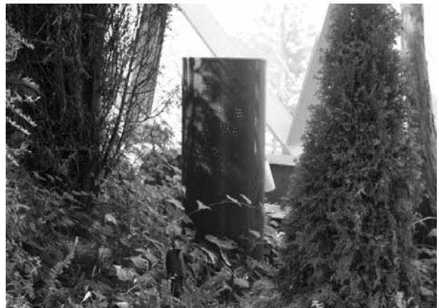
図8 植栽エリアのラウンドタイプ吹出口
