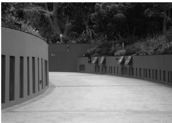
図6 見学者通路の置換空調吹出口(事例2)
