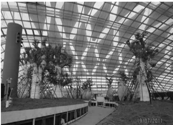
図6 見学者通路の置換空調吹出口(事例2)
