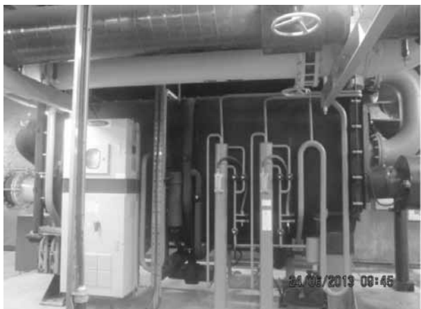
図14 吸収式冷凍機
