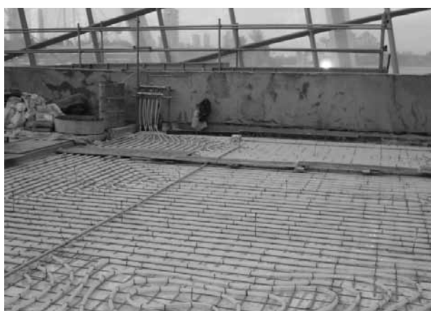
図10 クーリングチューブの施工状況
