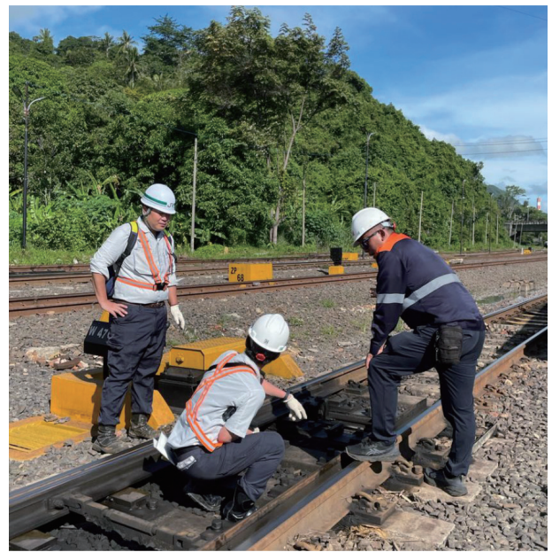
図4 インドネシアにおける現地鉄道会社との合同軌道調査の様子
