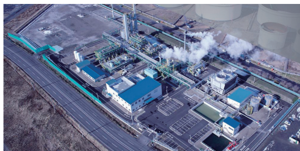
北海道・苫小牧市の CCS 実証試験 プラント全景
